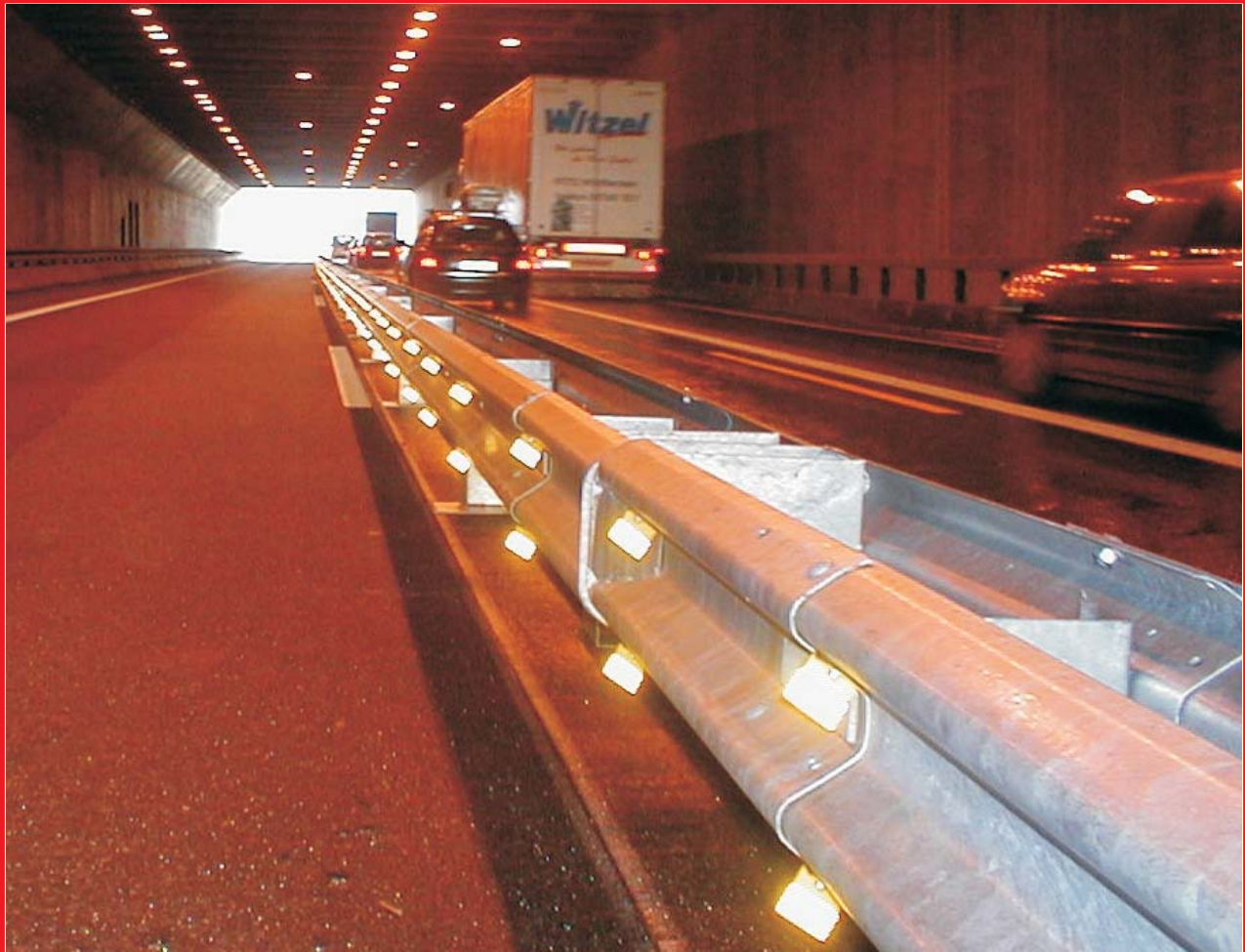
Die Stahlschutzwand Duo 4 mit BASt-geprüften Reflektorelementen (Prüf-Nr. V 4-08/2002)
