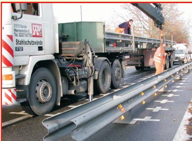
Schneller Aufbau durch 16-Meter-Bauteile
