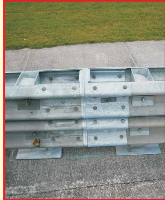
Kopfstück ermöglicht eine schnelle Montage
